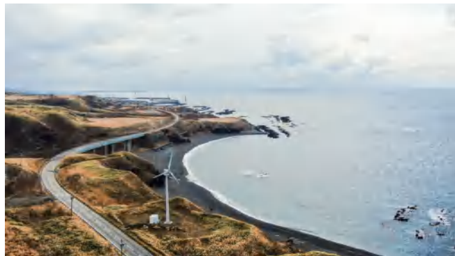
产品型号:FD16-19.2 项目地点:日本北海道 运行时间:2019年
