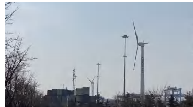
产品型号:FD25-100 项目地点:青岛港 运行时间:2021年 项目说明:园区分布式供电
